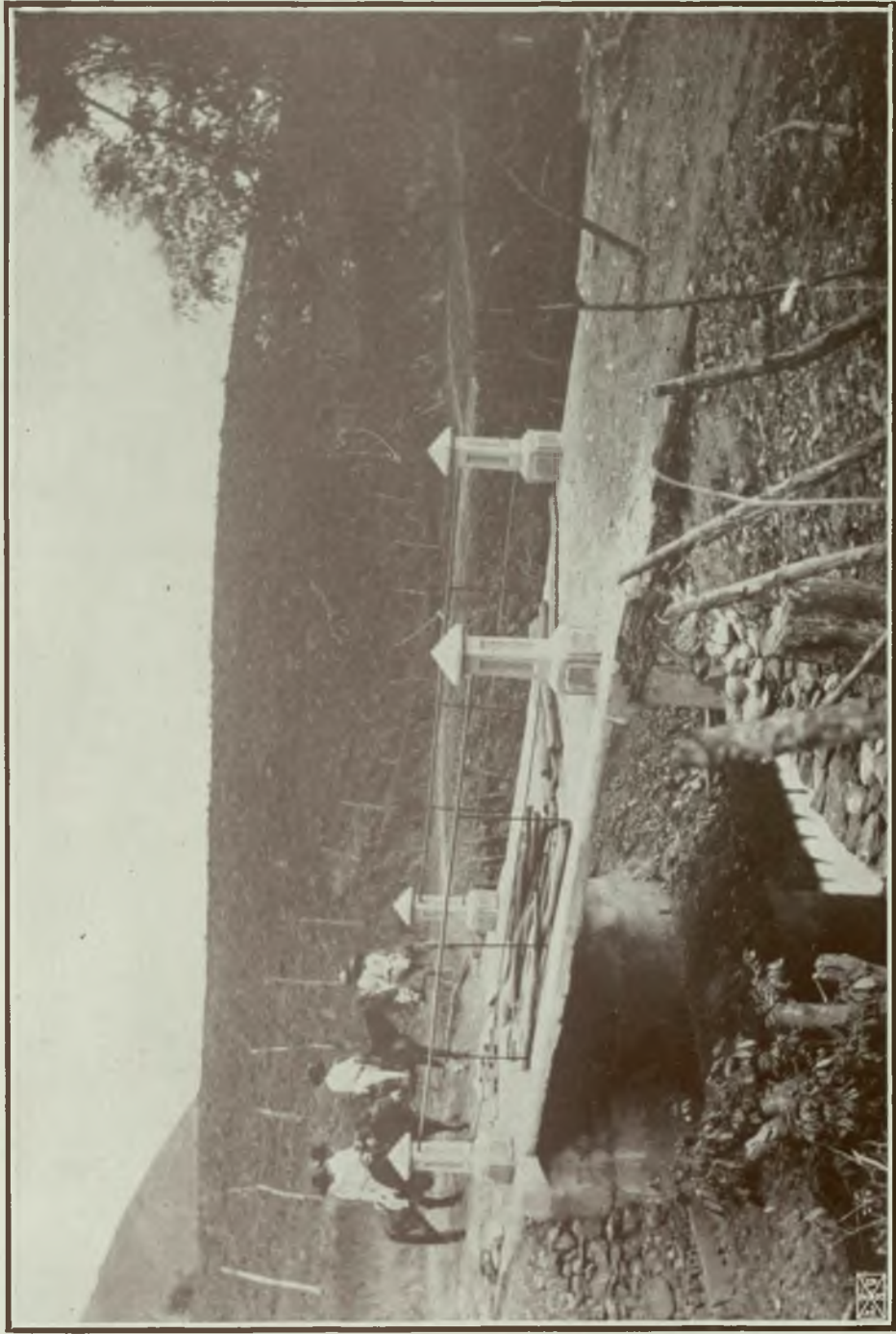
Carretera entre Villa de Cura y Calabozo.—Puede de concreto armado sobre el río Tucutunemo (en construcción) Morros de San Juan.
