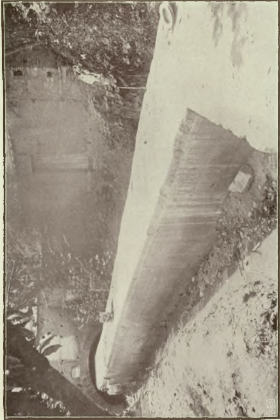
Cloacas de Caracas.—Colector de la quebrada "Cienfuegos".—Extremidad ya concluida hacia la esquina de El Cristo.
