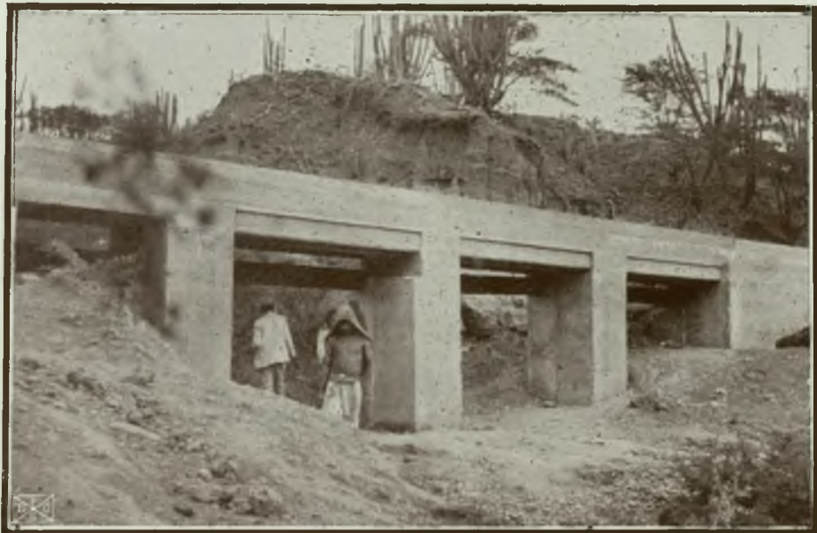
Reconstrucción del Dique de Caujarao.—Canal de Irrigación. Puente No. 1.
