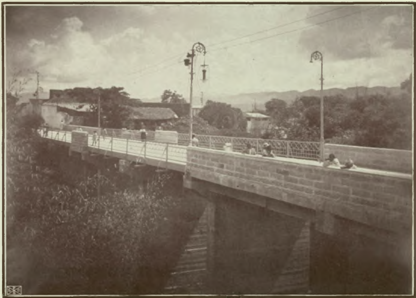
Puentes de la Calle Este 5.—Puente entre las esquinas de Santa Bárbara y Los Canónigos. Caracas.—Vista lateral del puente.—Parte Norte.
