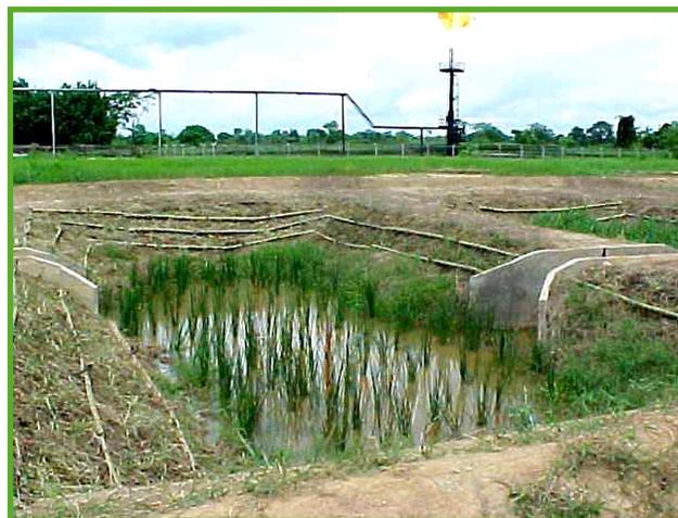
Fig. 2 Fotografía de celdas de los humedales construidos a escala piloto con tres meses de desarrollo en la Estación de flujo La Victoria y constituidos por las especies vegetales *Echinochloa polystachya* (izquierda) y otro constituido por *Typha domingensis* (derecha)
