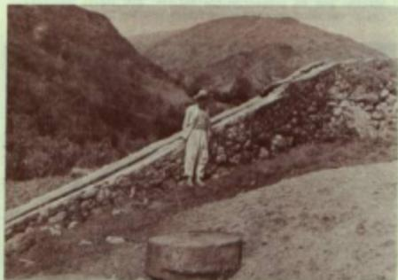
Aquí tienen la cañería del molino por donde baja el agua. El campesino de la gráfica ha logrado una verdadera obra de "ingeniería" fuerte y sólida, al construir estos muros de piedra y el canal por donde baja el agua utilizada.
