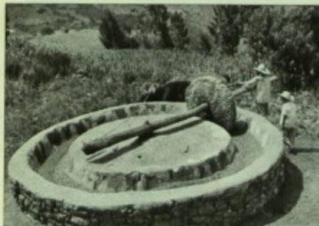
El mecanismo de la trilladora es muy elemental. Se compone de un tanque circular acanalado donde se echa el café y de una piedra rústica atravesada con un palo y movida por los mansos bueyes, que el hombre arrea con su garrocha
