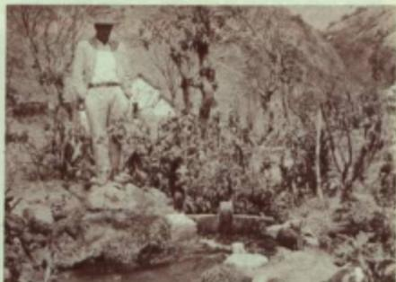
En los lugares donde se hace la toma del agua, se colocan estas compuertas con el objeto de desviar la corriente hacia el molino. Hecho el trabajo, el agricultor observa su labor con el objeto de rectificar los posibles errores.
