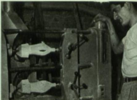
Con un torno-pantógrafo que funciona bajo la vigilancia de un operario experto, el trozo de madera desbastada inicialmente, sufre otra transformación. Cuando ésta concluye, las unidades quedan listas para continuar el proceso.
