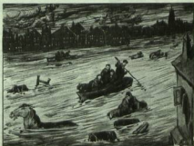
7 de enero de 1928: El Támesis se desborda a la altura de Londres y ocasiona una de las mayores inundaciones registradas en la historia de dicho río. Hubo muchas víctimas.
