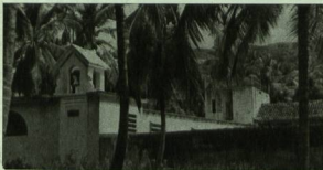
El edificio de administración de la hacienda sirvió para beneficiar el café de las plantaciones, hoy abandonadas tal vez a causa del bajo precio del grano, o del éxodo campesino. Cerca de los grandes patios para secar la cosecha, alzáse una hermosa capilla donde el vecindario devoto puede oír su misa dominical.
