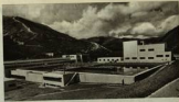
"La Mariposa" tiene capacidad de almacenamiento para cuatro millones de galones adicionales a una reserva del millón de litros. La capacidad del "La Mariposa" está a la mano cuando la zona de las 7,000,000 galones de agua que se bombea al sistema y se emplea para producir 10 millones de galones de agua potable al día.
