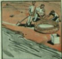
**LA CASIMBA.**—En el Estado Falcón y en ciertas regiones limítrofes con el Estado Lara, suele llamarse "casimba" a un pozo de unos tres o cuatro metros de profundidad, construido a la orilla de los ríos y el cual se llena por filtración. El agua depositada allí se emplea para usos domésticos o agrícolas.
