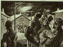
31 de diciembre de 1879.—Tomás Alba Edison ofrece una exhibición pública de su sistema de iluminación eléctrica. Ilumina un distrito de Menlo Park, New Jersey.
