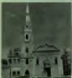
En el centro de Maracaibo, en el Bulevar "Barral", frente a la Plaza del mismo nombre, vemos la Iglesia de San Francisco, sencilla y bella de gracia.
