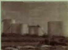
Los depósitos que contienen millones de litros de petróleo están protegidos por altas alambradas, con el objeto de impedir el tránsito por el lugar y evitar incendios. Esta medida de seguridad es muy corriente en los campos petroleros.
