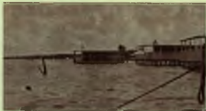
Las construcciones de la Bahía Blanca de Nueva Guinea son pequeñas viviendas con techos de paja, construidas, segun dicen para protegerse de la lluvia, sobre pilas de piedras blancas del Lago. Estas casas pueden resistir terremotos de moderada intensidad y incendios. Tanto el interior, las plazas de baile y las construcciones.
