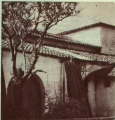
Aquí puede verse el contraste. Parte de las paredes exteriores que amenazaban derrumbarse, vencidas ya por el tiempo implacable que todo lo destruye, fueron completamente reconstruidas. Se tuvo cuidado, al hacer los trabajos de conservar el estilo arquitectónico de la construcción.
