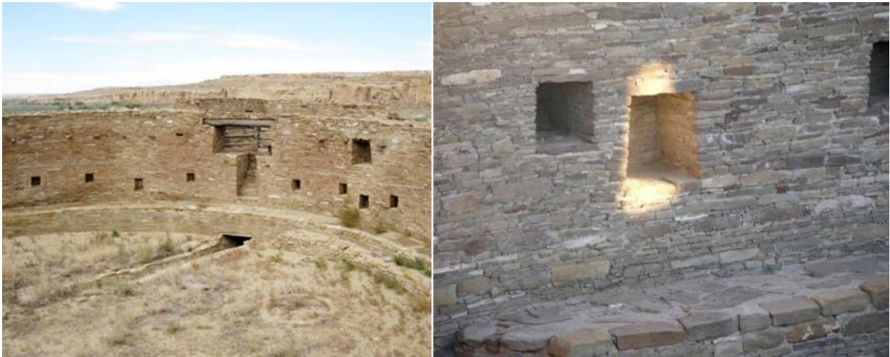
Interior de Casa Rinconada, en la que aparecen seis nichos superiores y dos inferiores (izquierda). La luz solar entra por la ventana e ilumina un nicho en Casa Rinconada, poco después de salir el sol en un 21 de junio (derecha).
