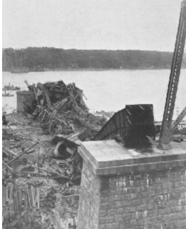
Dos fotografías del puente: una tomada justo antes de que se derrumbara y otra después.
