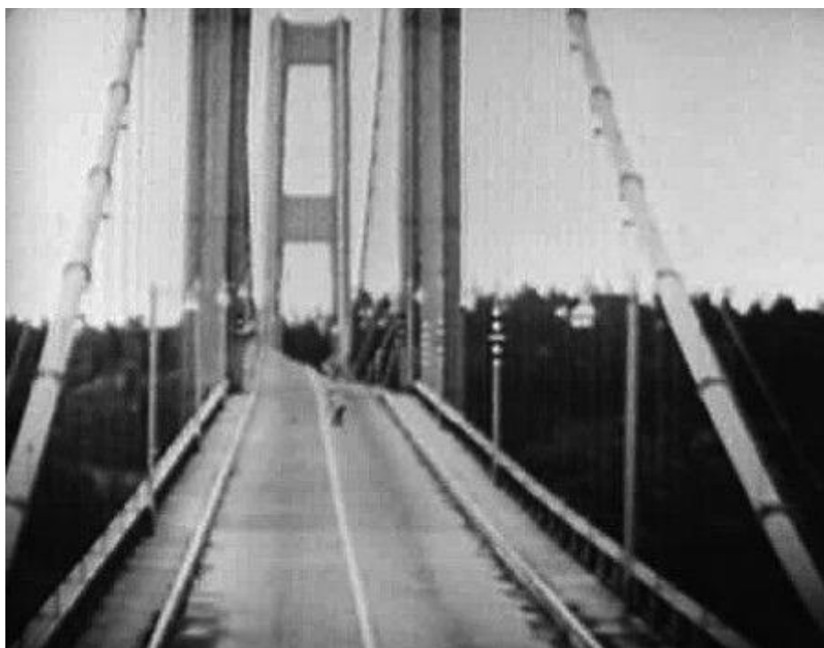
Imagen: El puente de Tacoma en pleno proceso de resonancia. (Foto: archivos del autor)
