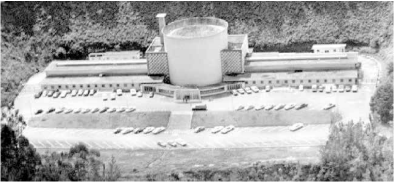
Reactor nuclear instalado en el IVNIC
