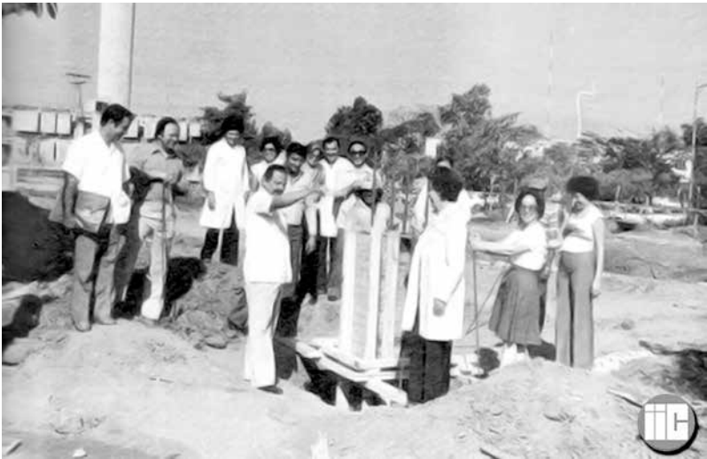
Construcción del Instituto de Investigaciones Clínicas (1978) en el estado Zulia
