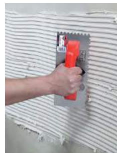
Peinado del cemento cola sobre el soporte
