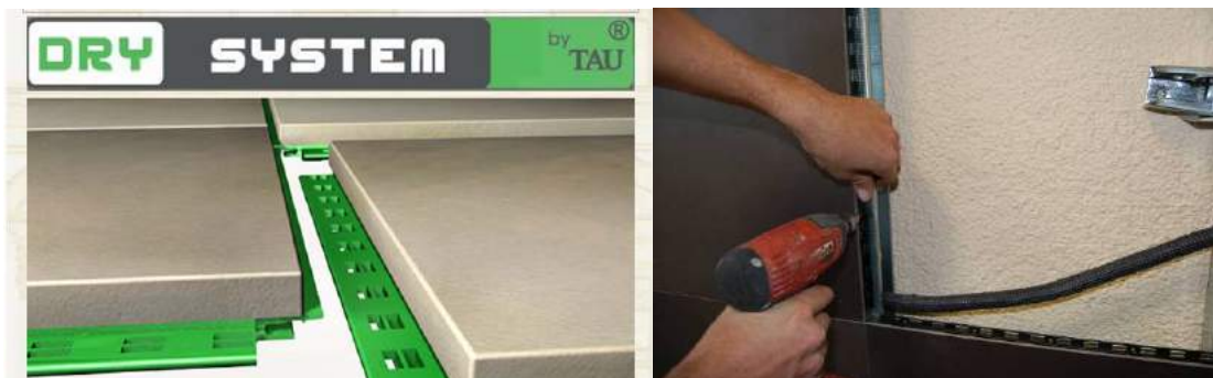
Drysystem. Instalación de pavimento y revestimiento. Tau cerámica
