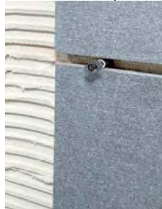
Fijación del anclaje de seguridad
