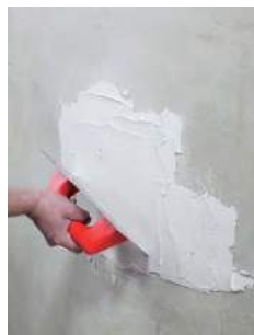
Aplicación del cemento cola sobre soporte
