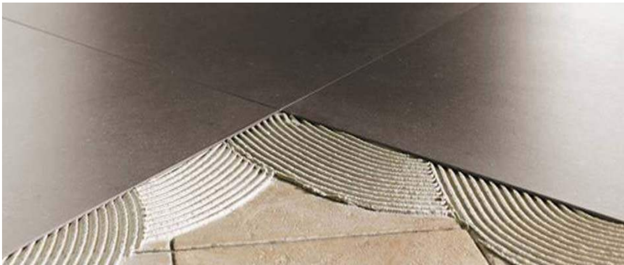
Instalación de lámina cerámica sobre soporte existente
