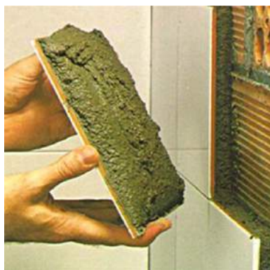
Instalación de azulejo en capa gruesa
