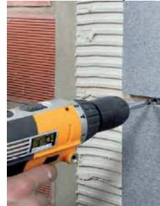
Apriete del anclaje de seguridad
