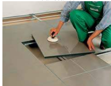
Instalación de los paneles
