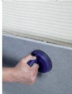
Instalación de la baldosa cerámica
