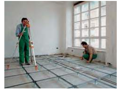
Puesta en cota de la estructura
