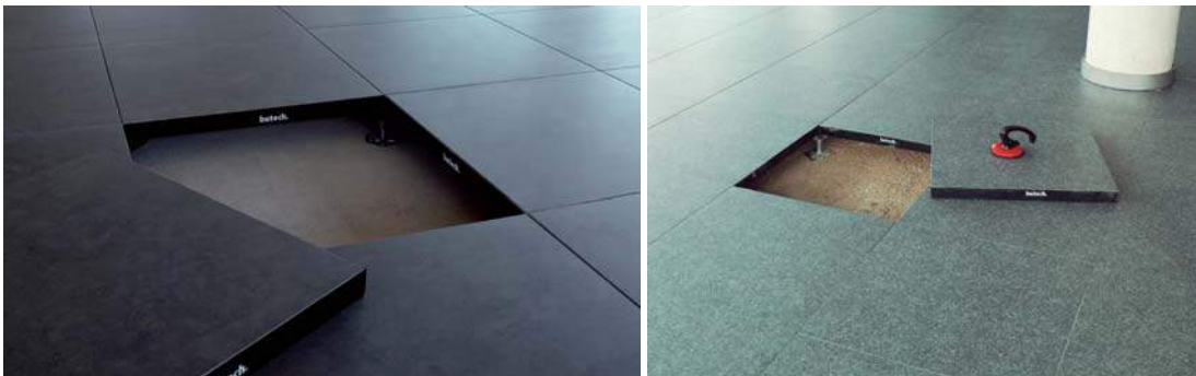
Instalación de suelos técnicos. Butech
