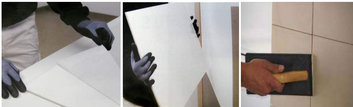
Imágenes de Rehabilitación mediante sistemas Wandefix. Wandegar
