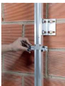
Ensamblaje de la garra de arranque al anclaje
