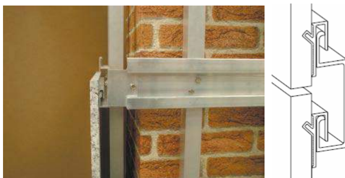
Detalle sistema oculto Karrat S-7. Mecanofas
