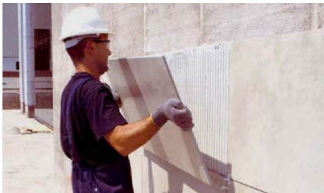
Instalación de fachada aplacada en capa fina
