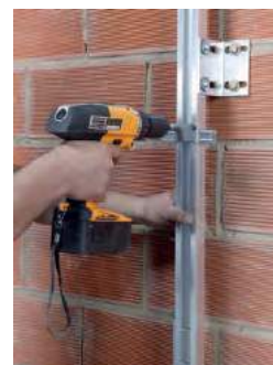
Instalación del anclaje sobre el perfil vertical
