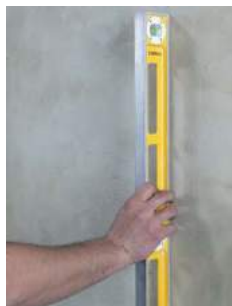
Comprobar la planeidad del soporte
