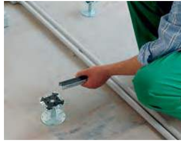
Encastres de los pedestales con los travesaños
